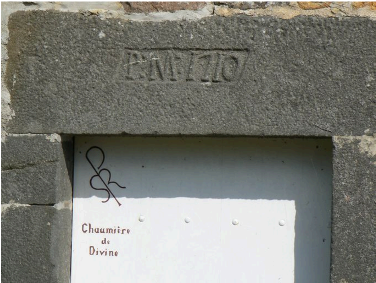
Détail de la porte et du linteau
