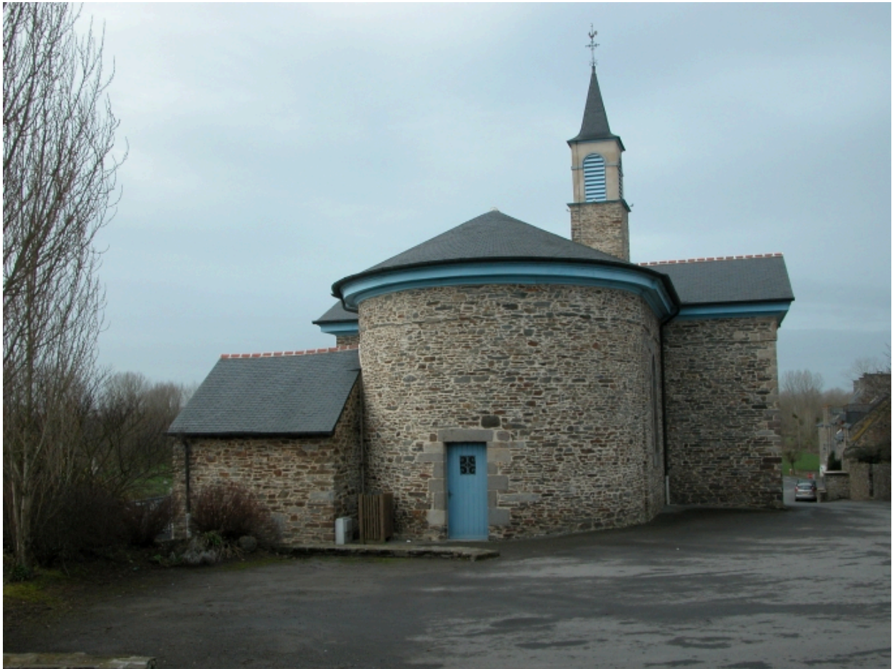
Elévation Ouest : vue générale
