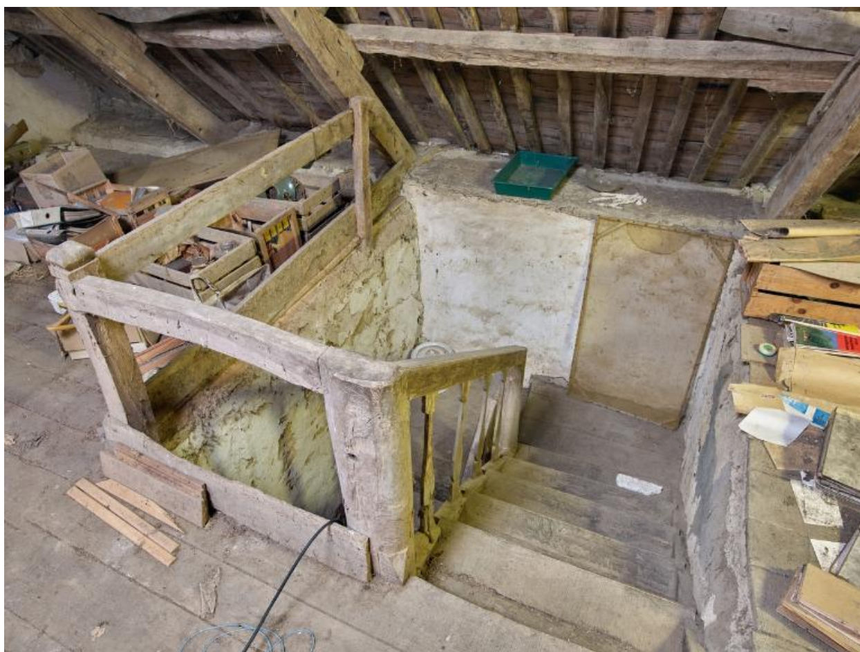
La cage d'escalier depuis le grenier
