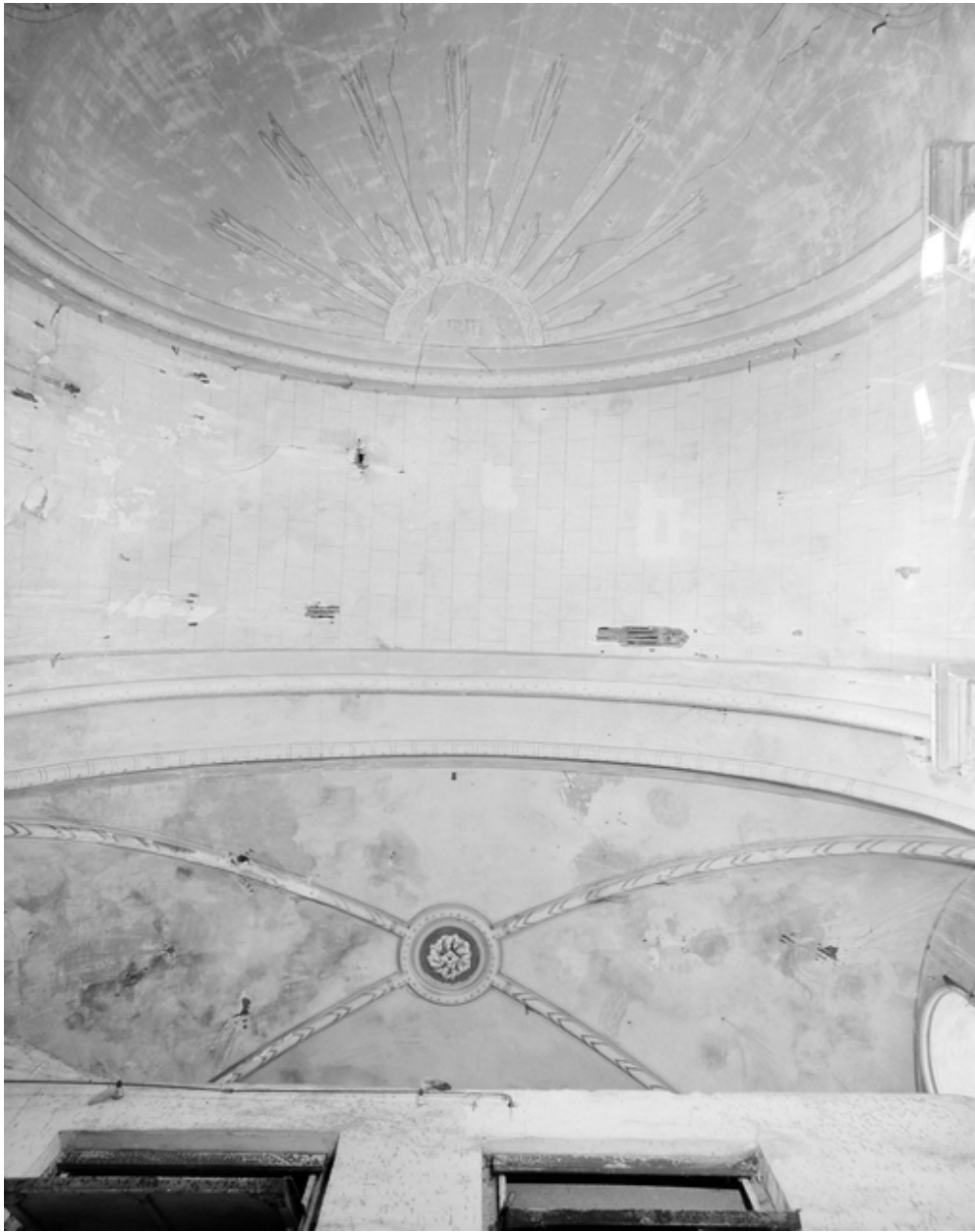
Intérieur, plafond : détail
