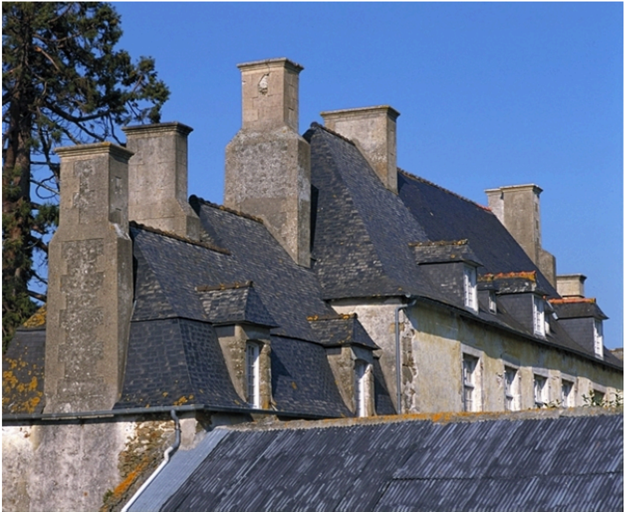
Les souches de cheminée : vue générale ouest
