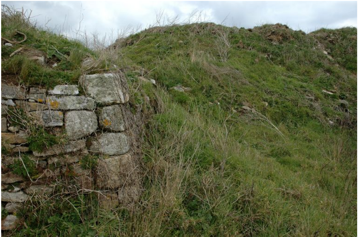
Vue du chaînage en pierre de taille de granite du parapet (état en 2006)
