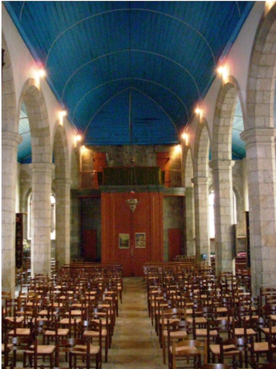
Port-Launay, église paroissiale Saint-Nicolas : vue axiale ouest
