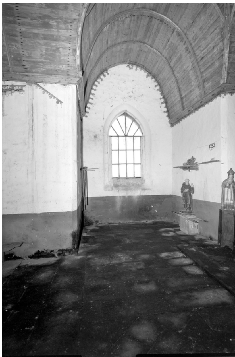
Vue du bras nord du transept
