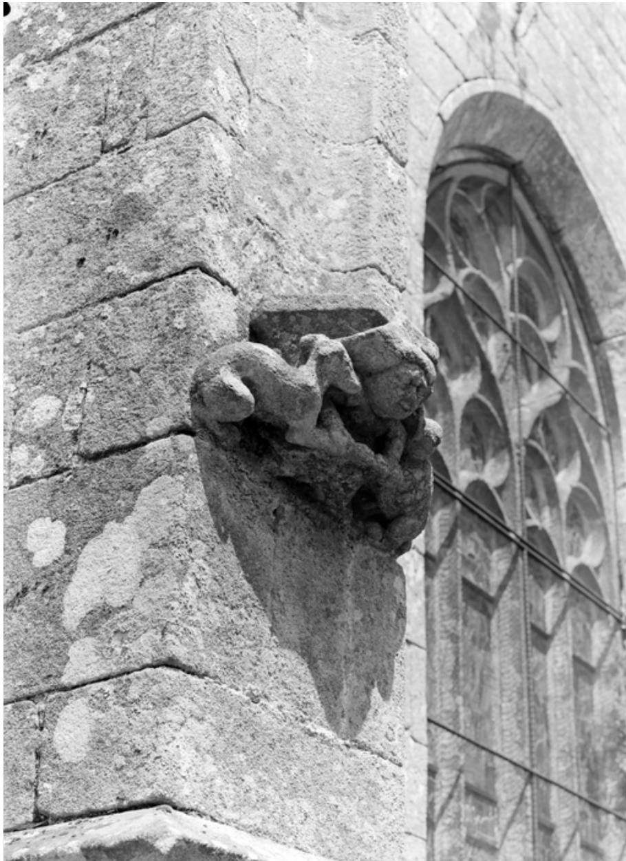
Façade sud, pignon du croisillon, détail du contrefort sud, angle sud-ouest, console de la niche.
