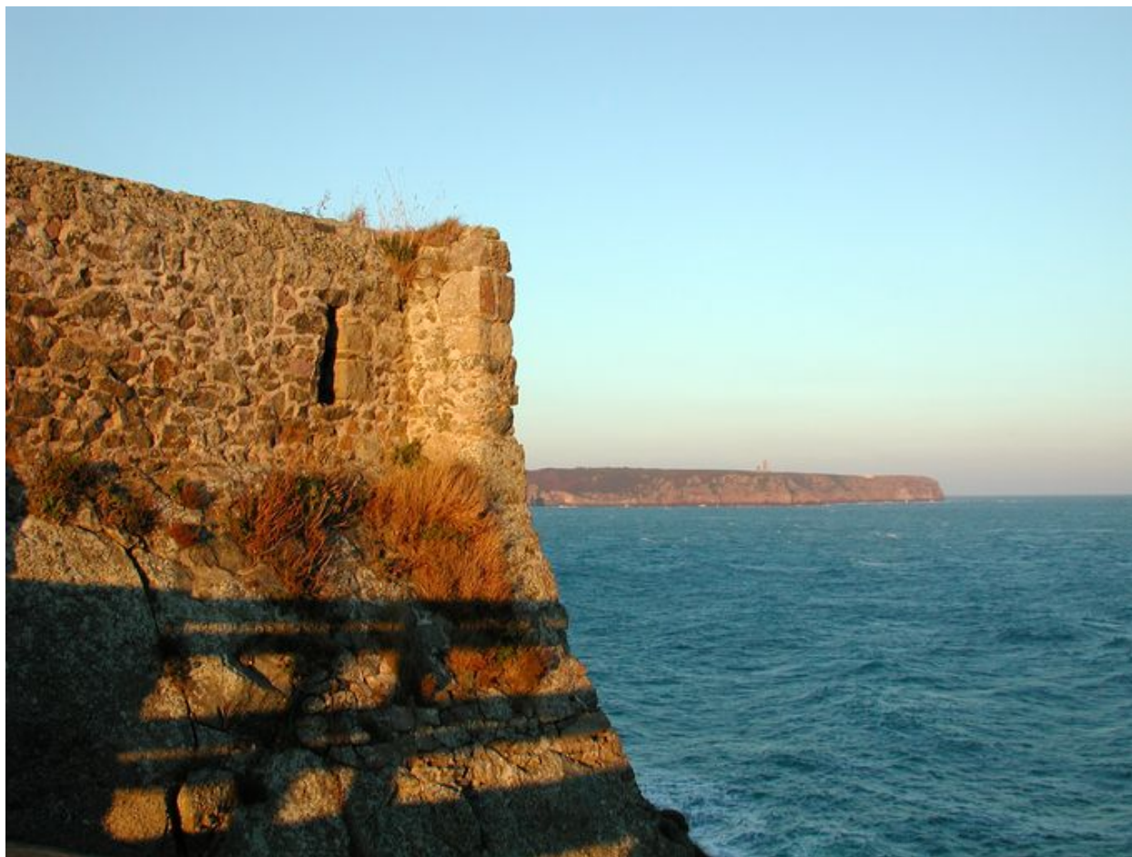
Vue du Fort La Latte
