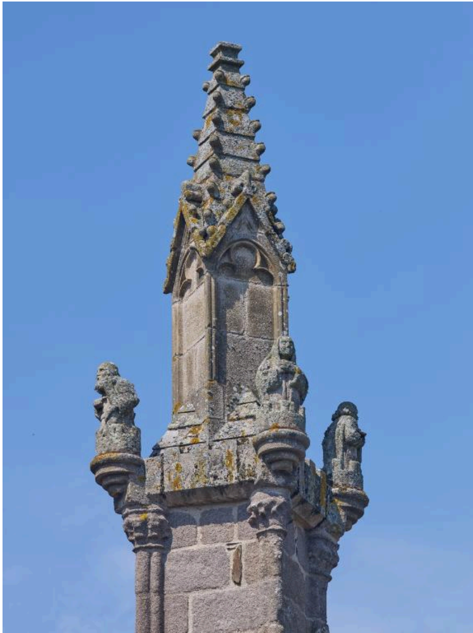
Détail de l'un des pinacles des contreforts du chevet
