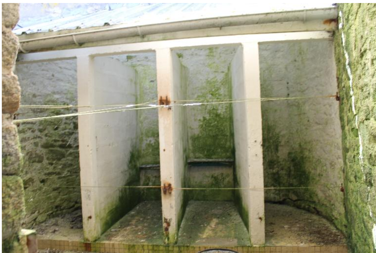
Lieux d'aisance ou latrines (angle est)
