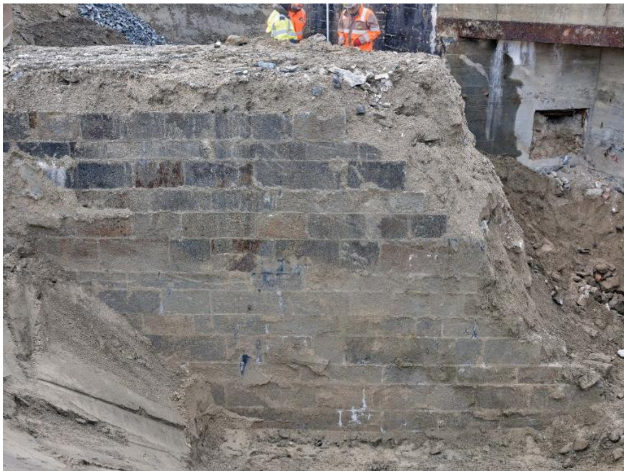
Vue des vestiges du quai de l'avant-port de Saint-Servan : élévation nord-est, maçonnerie en pierre de taille de granite (couverture photographique du 22 janvier 2026)
