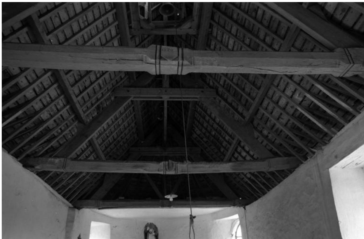
Vue de la charpente
