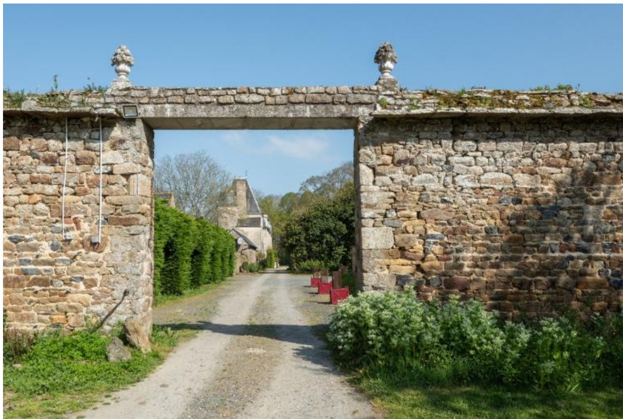
Mur de clôture
