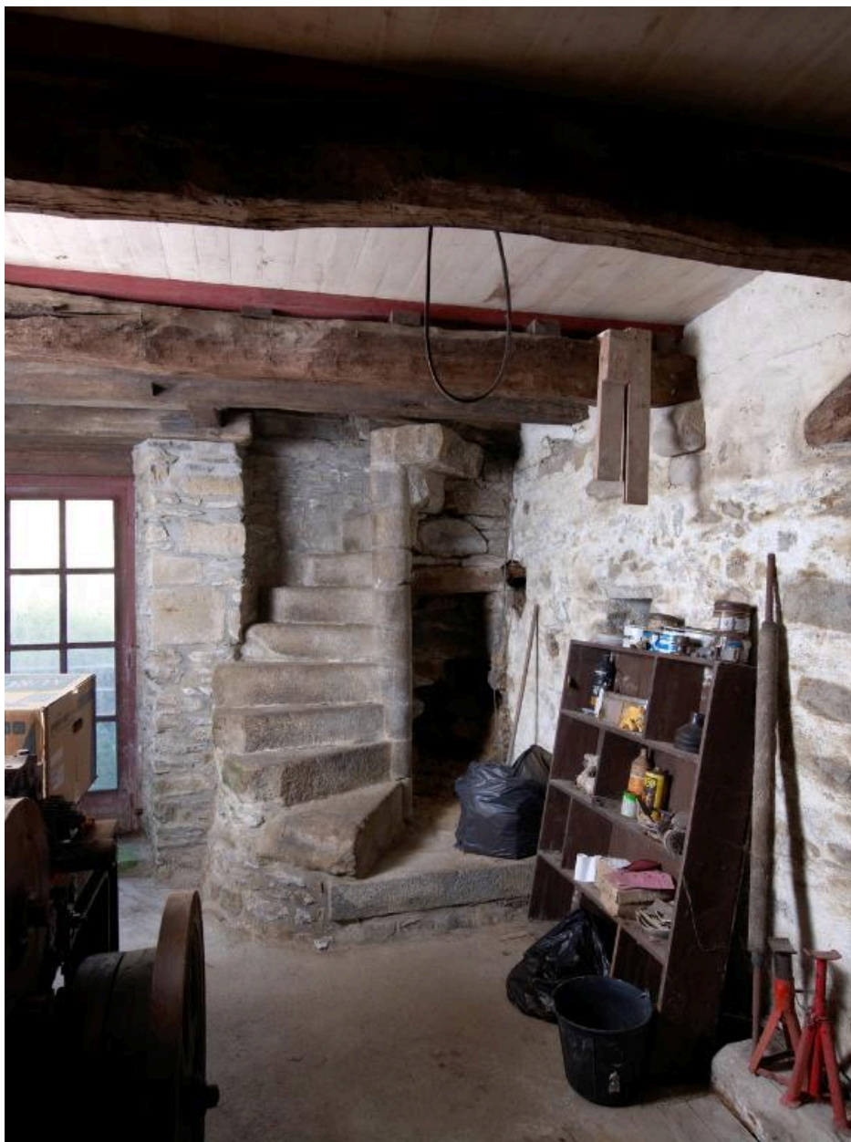
Tour d'escalier. Vue générale prise du sous-sol
