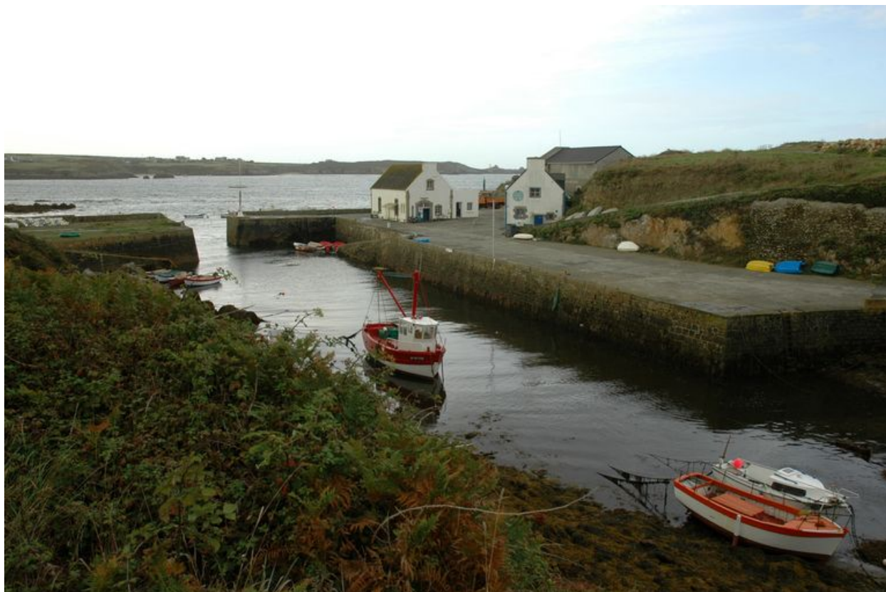
Vue du port-abri de Lampaul
