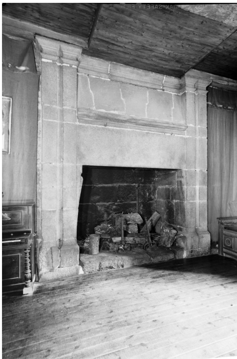
Rez-de-chaussée : pièce nord du corps principal, cheminée du mur nord
