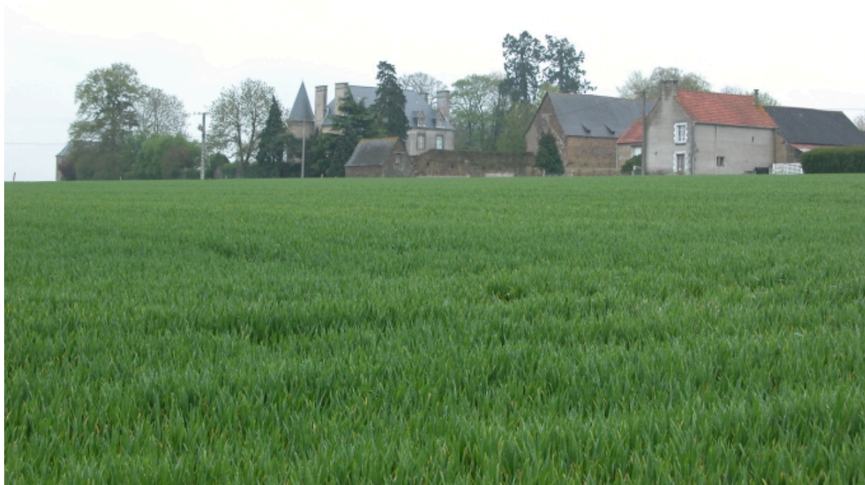
Vue de situation nord est
