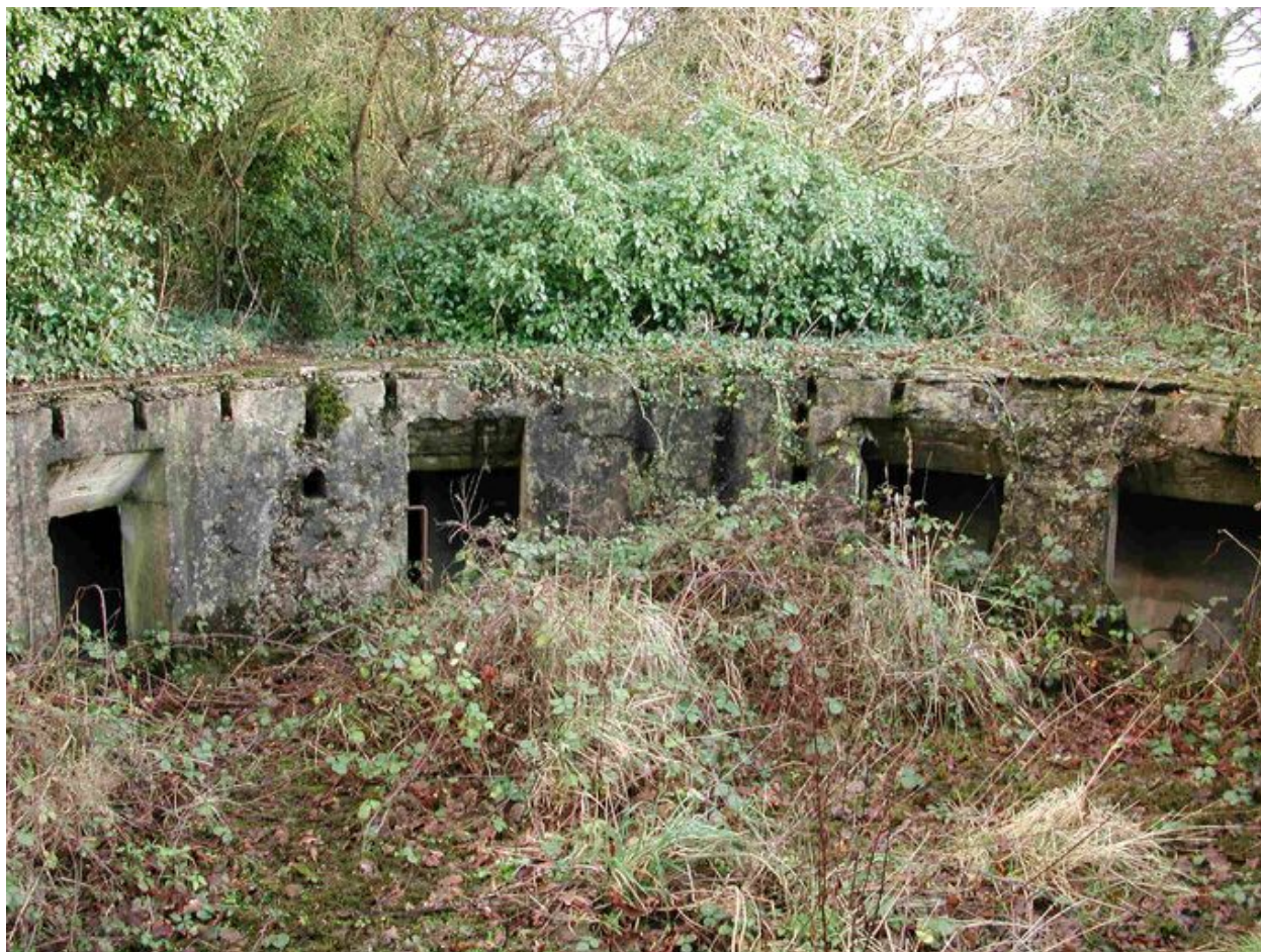
Vue de la batterie antiaérienne de Keroual : encuvement pour canon de 10,5 cm envahi par la végétation
