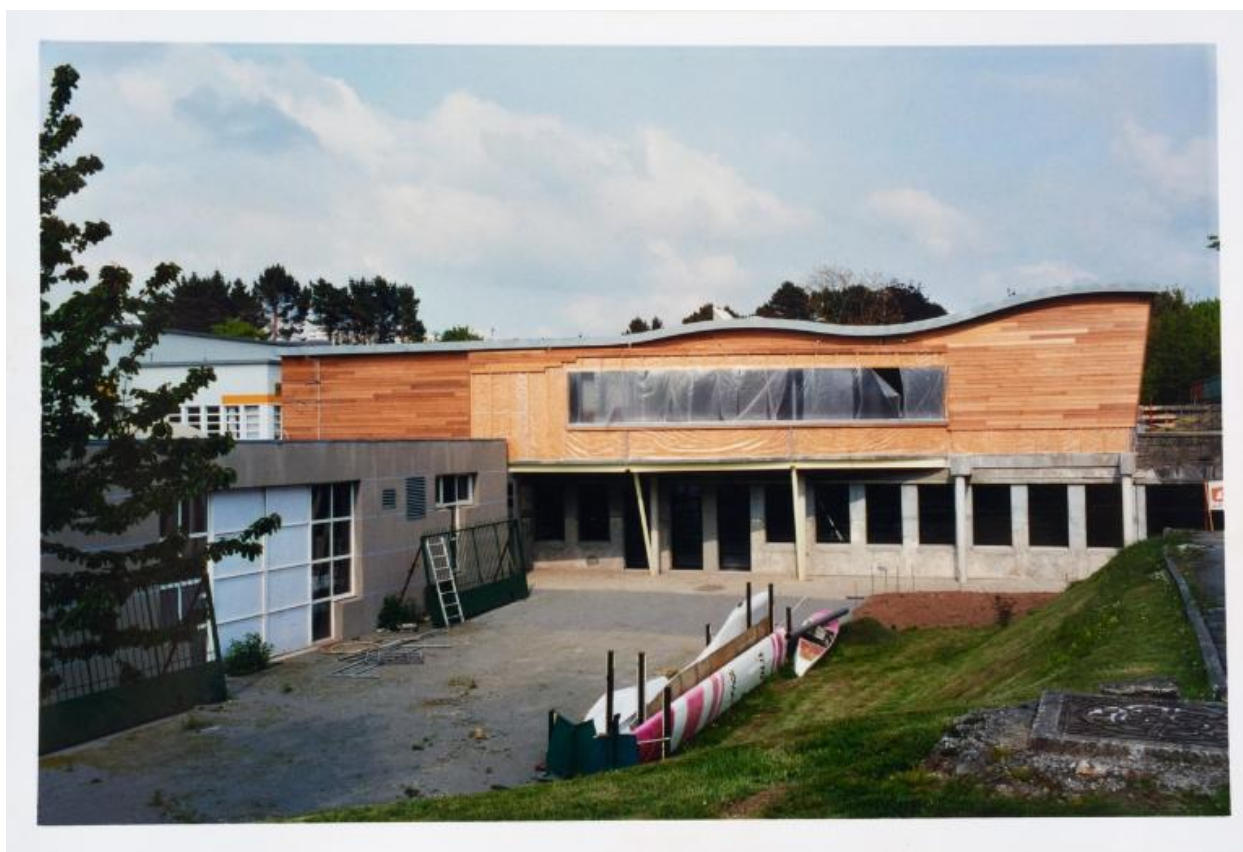
Vue de la façade ouest du CDI (Gildas Nédélec, architecte, 1997) en cours de construction.
