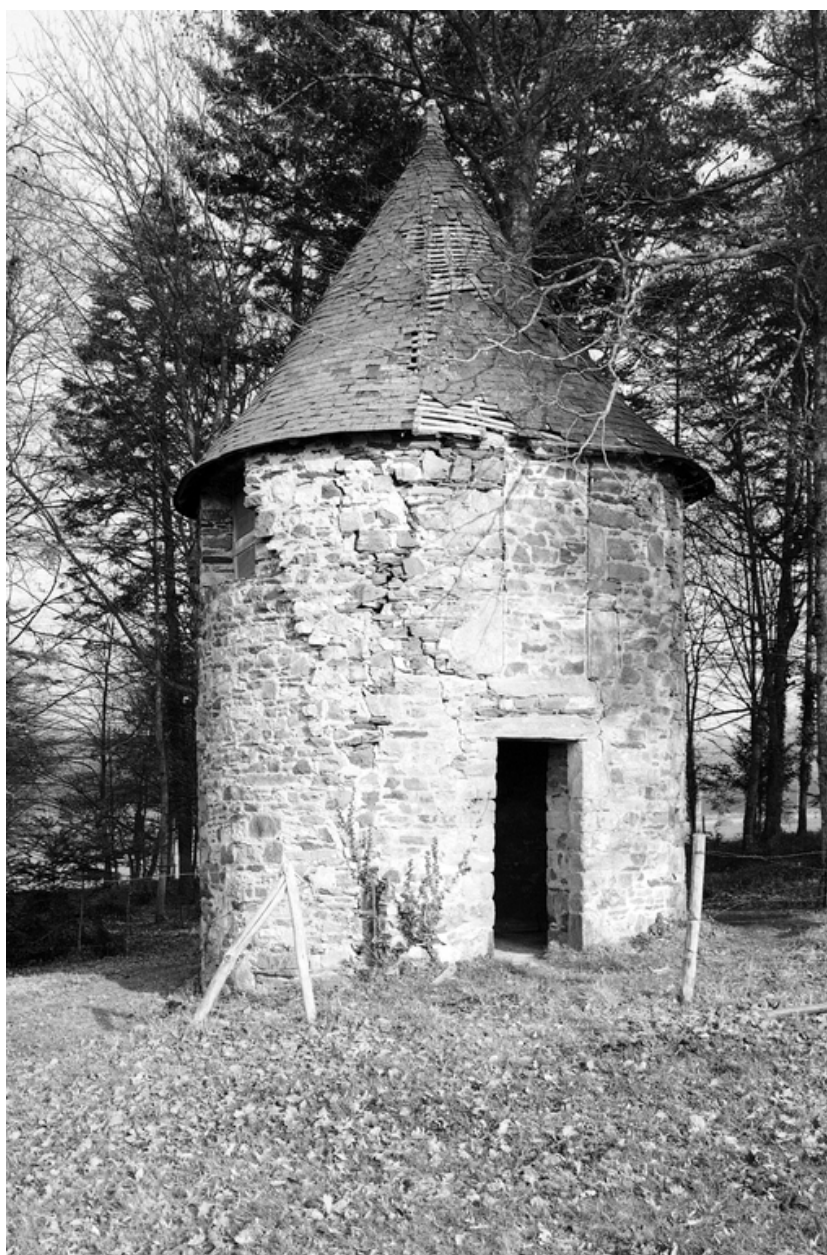
Tour nord est, vue générale.
