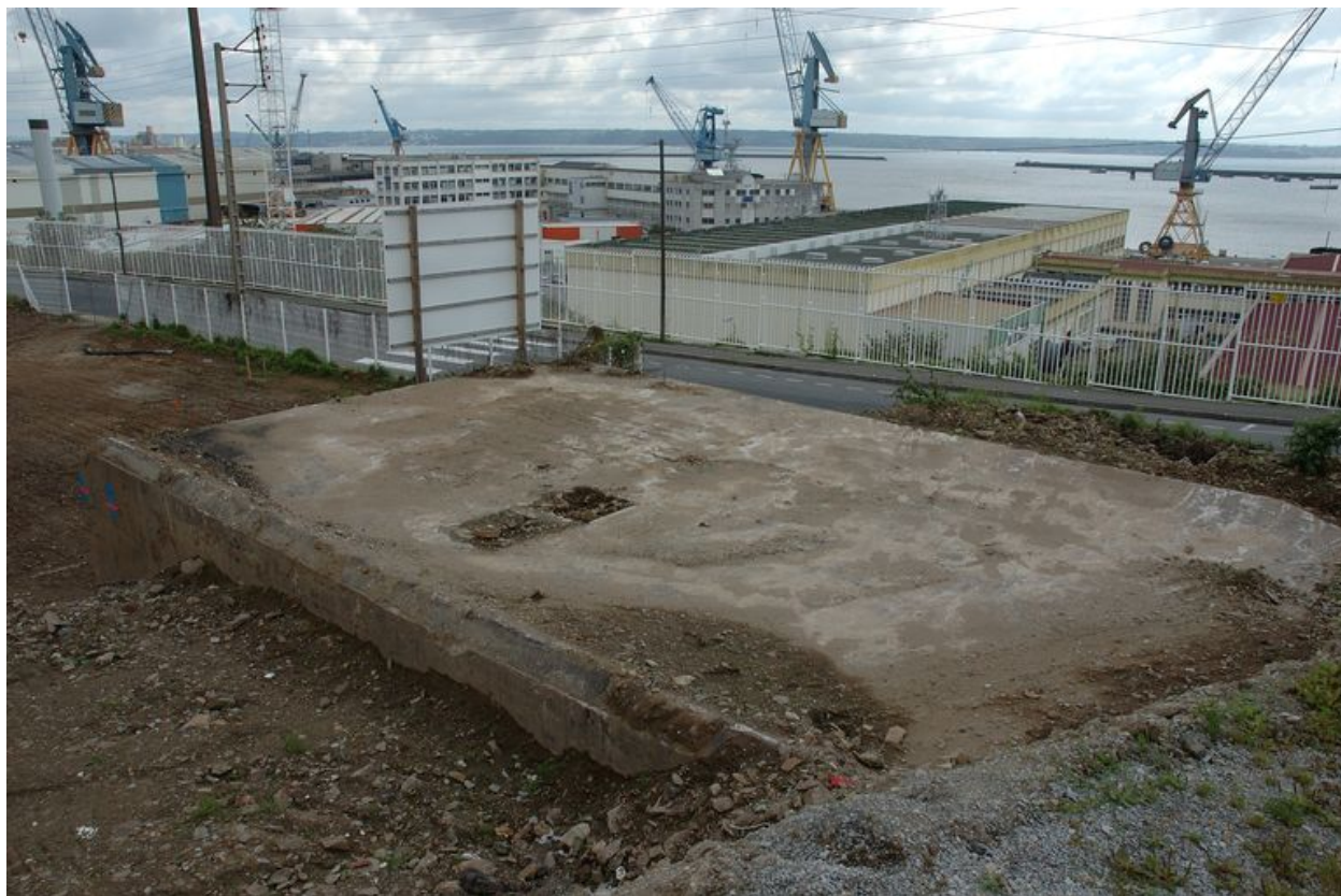
Vue de situation lors de travaux de construction de logements collectifs (état en 2008)
