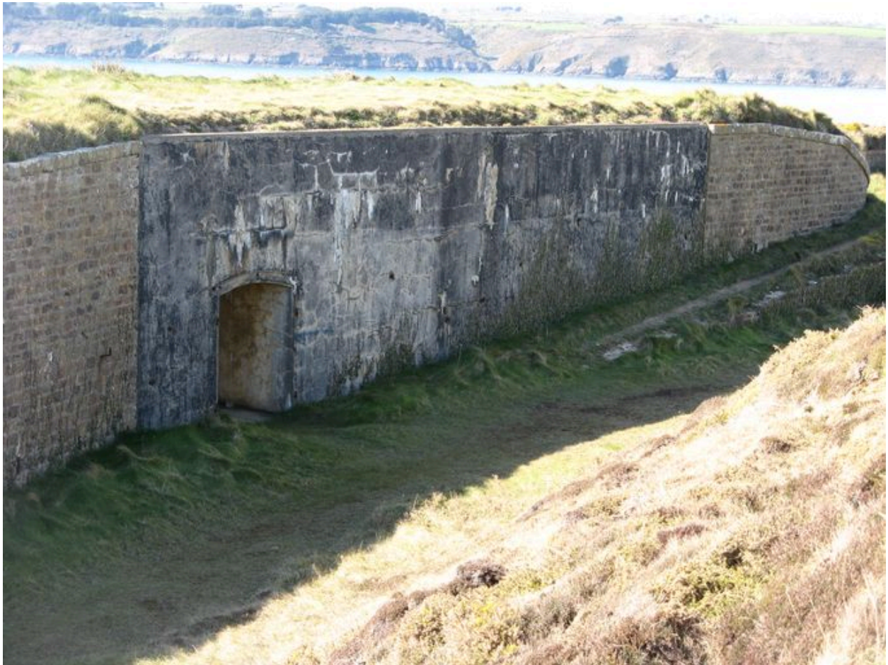
Route de service en tranchée avec magasin à munitions
