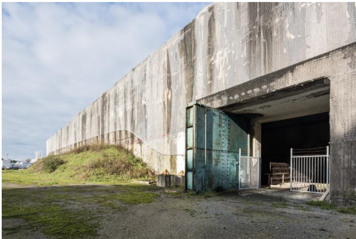
Vue générale de l'élévation sud et porte blindée constituant l'accès sud avec petite avancée de protection
