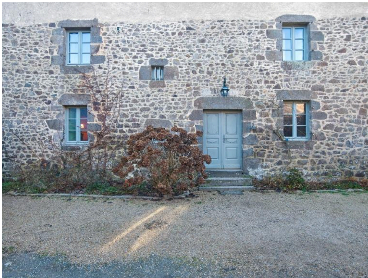
Logis. Façade nord
