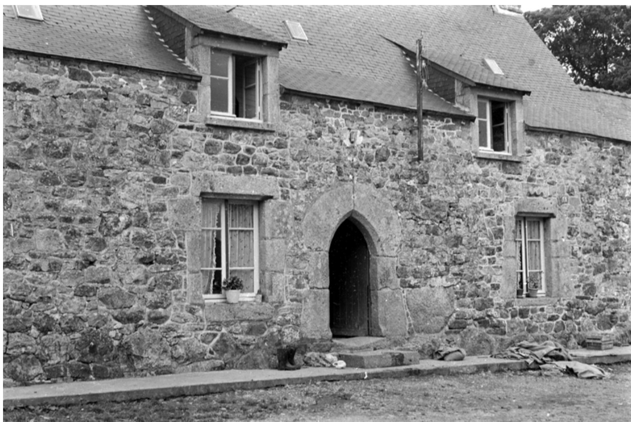
Maison (Kerhervé) : vue de la façade antérieure
