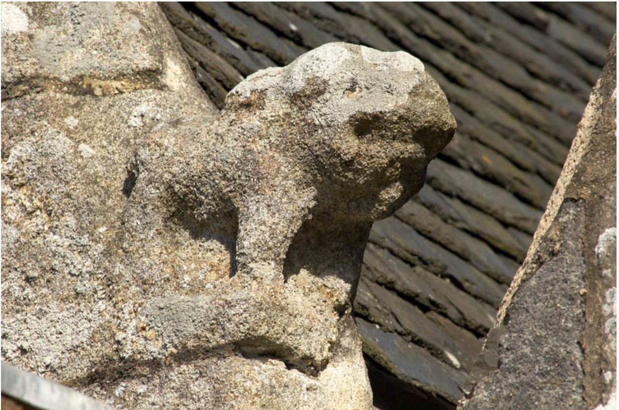
Détail d'une crossette de pignon.
