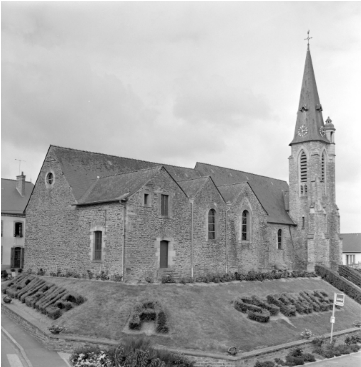
Elévation Nord-Est : vue générale
