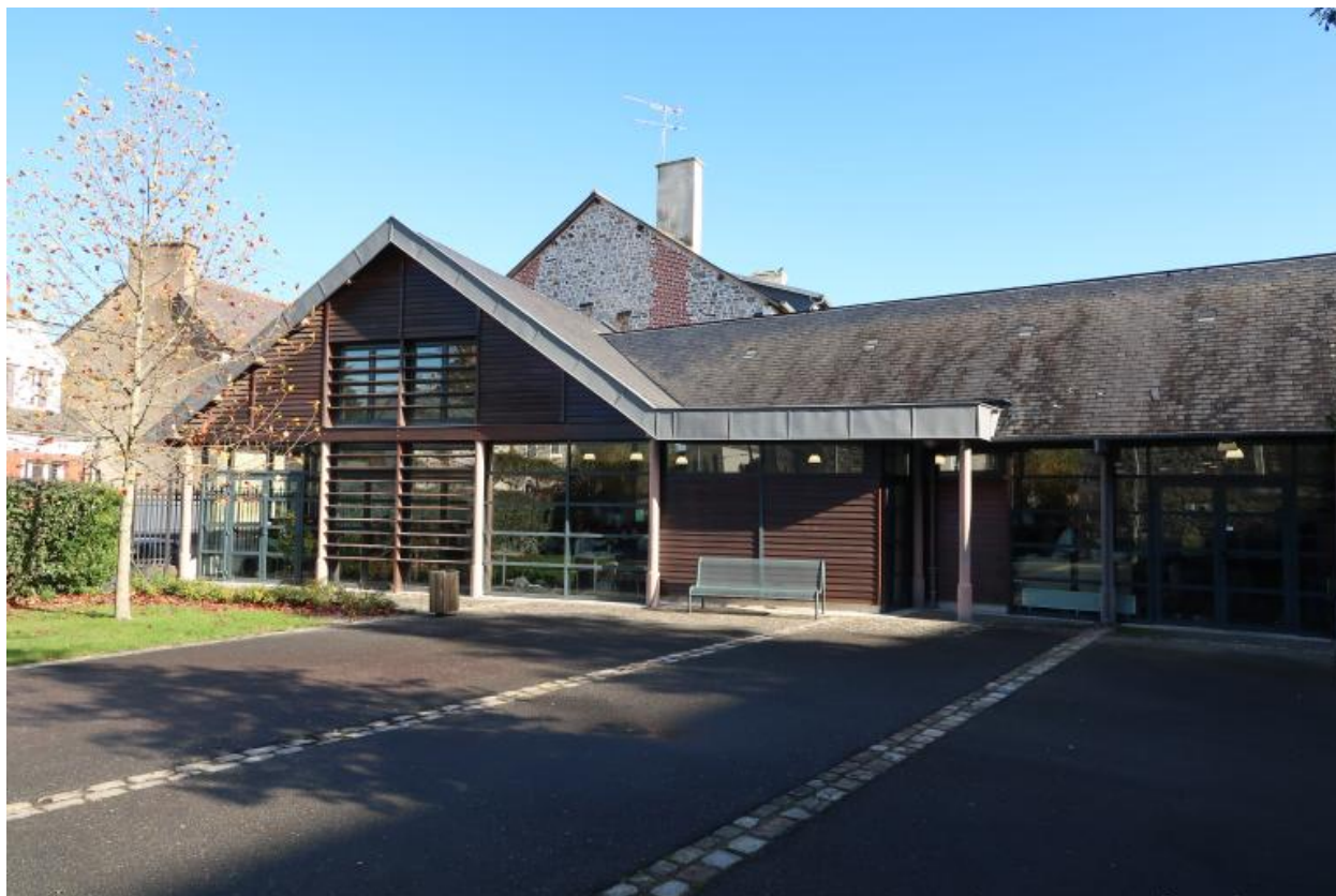
Le réfectoire, façade ouest.
