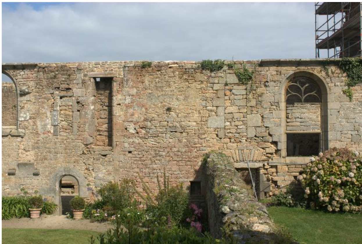
Vue sud de la partie centrale de la chapelle
