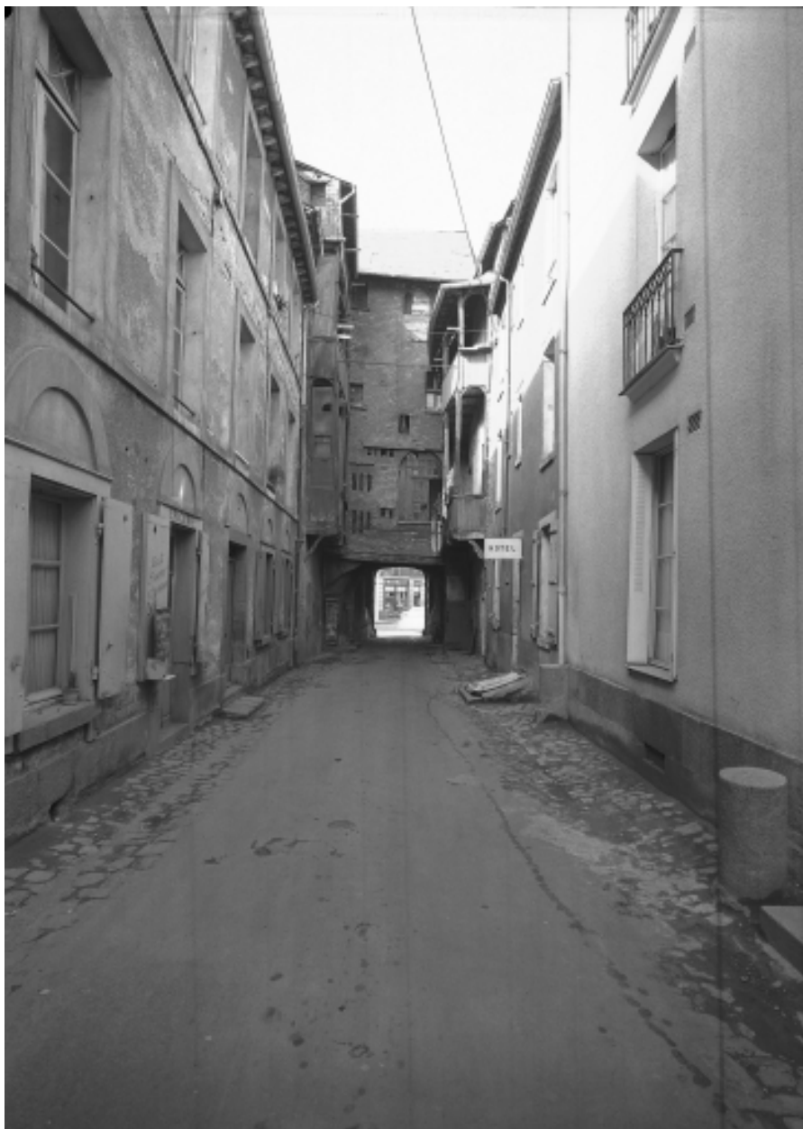
Façade postérieure : vue générale
