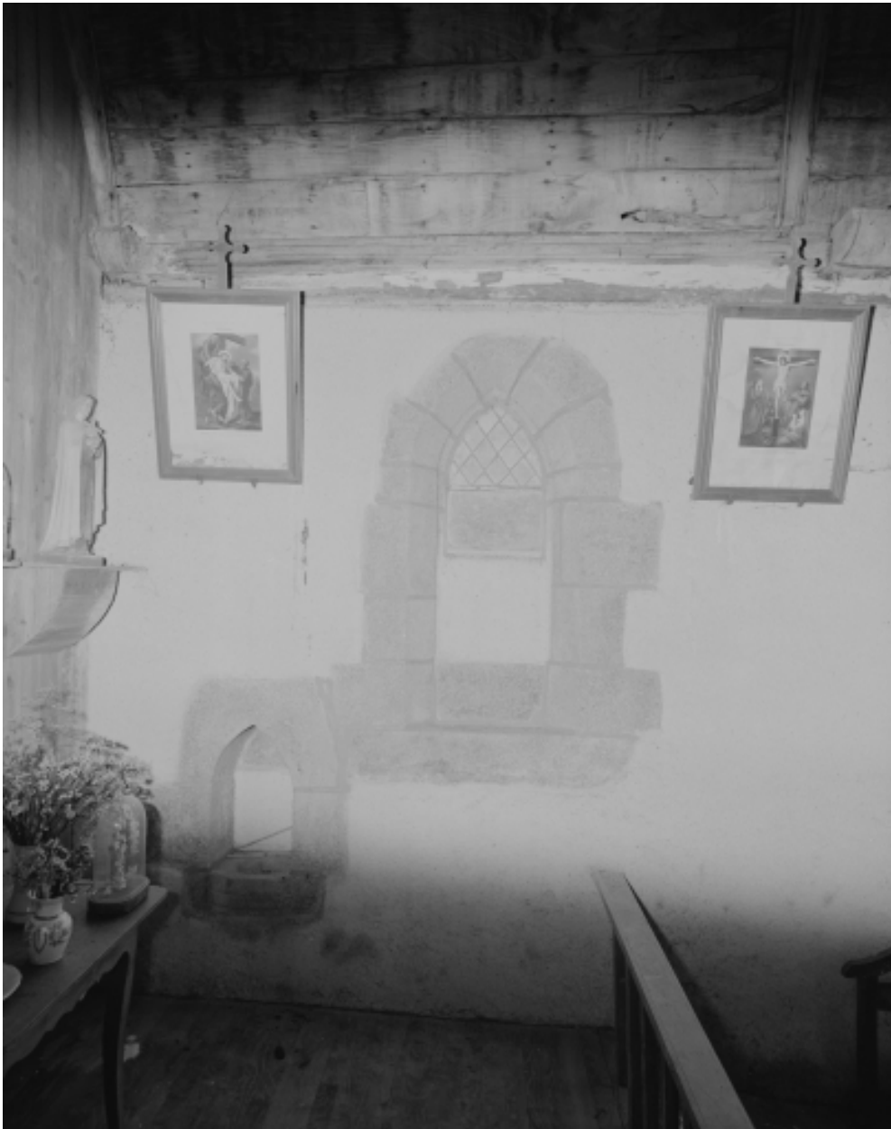
Intérieur, chœur, mur Sud, baie et lavabo : vue générale.
