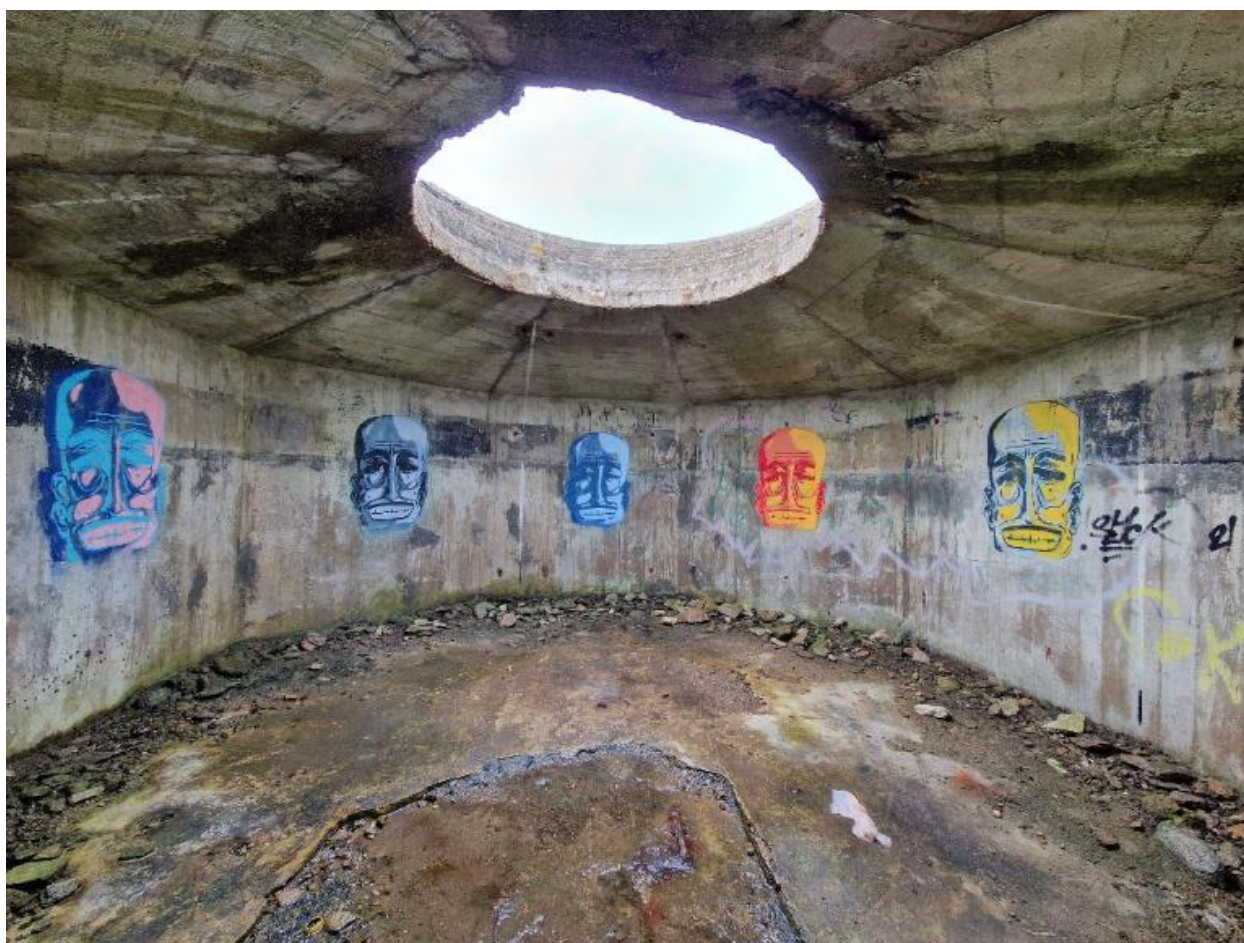
Vue intérieure : poste d'observation et de tir circulaire. Les murs sont tagués
