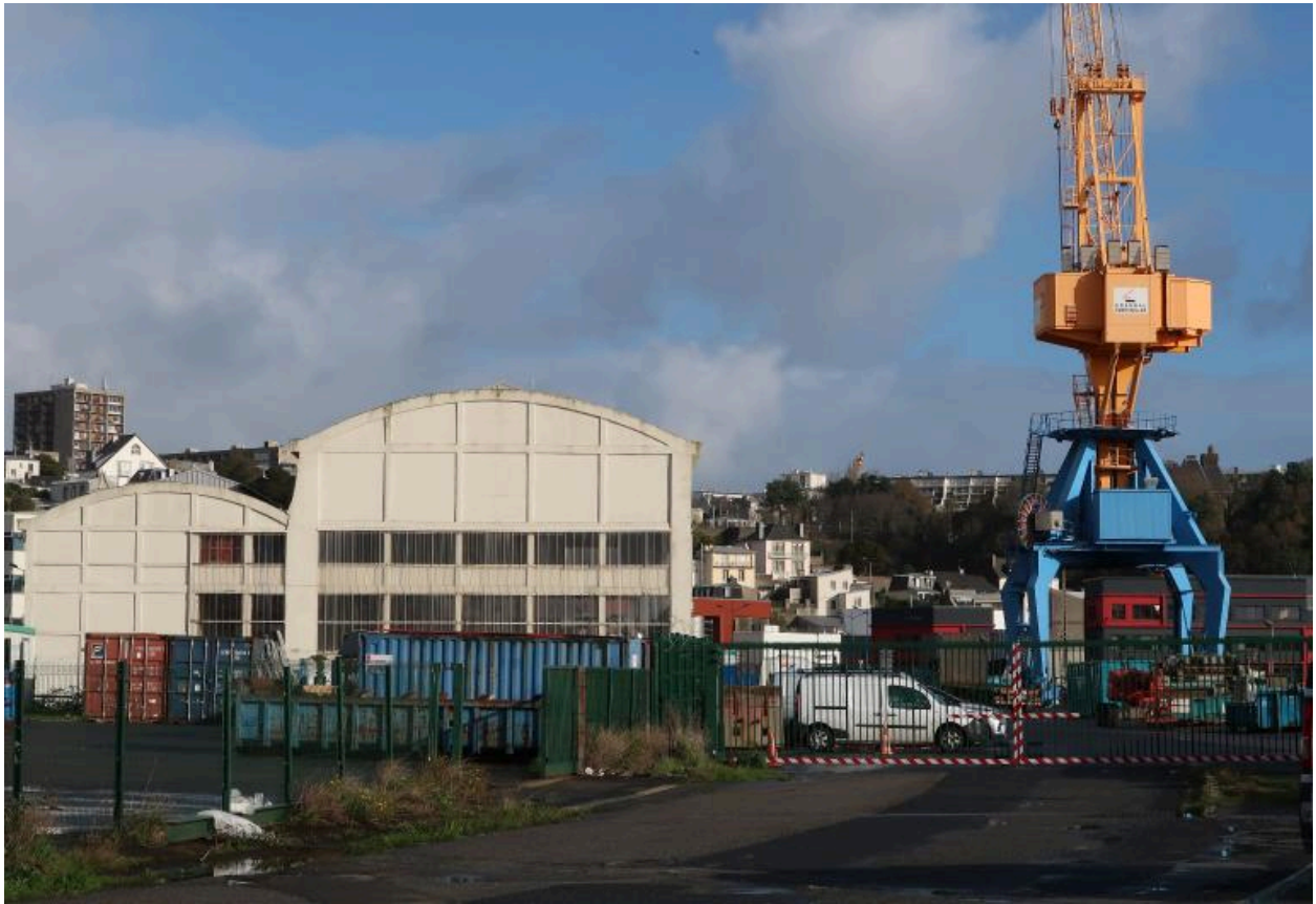
Hangar de réparation, ancien atelier Dubigeon, façade ouest, grue
