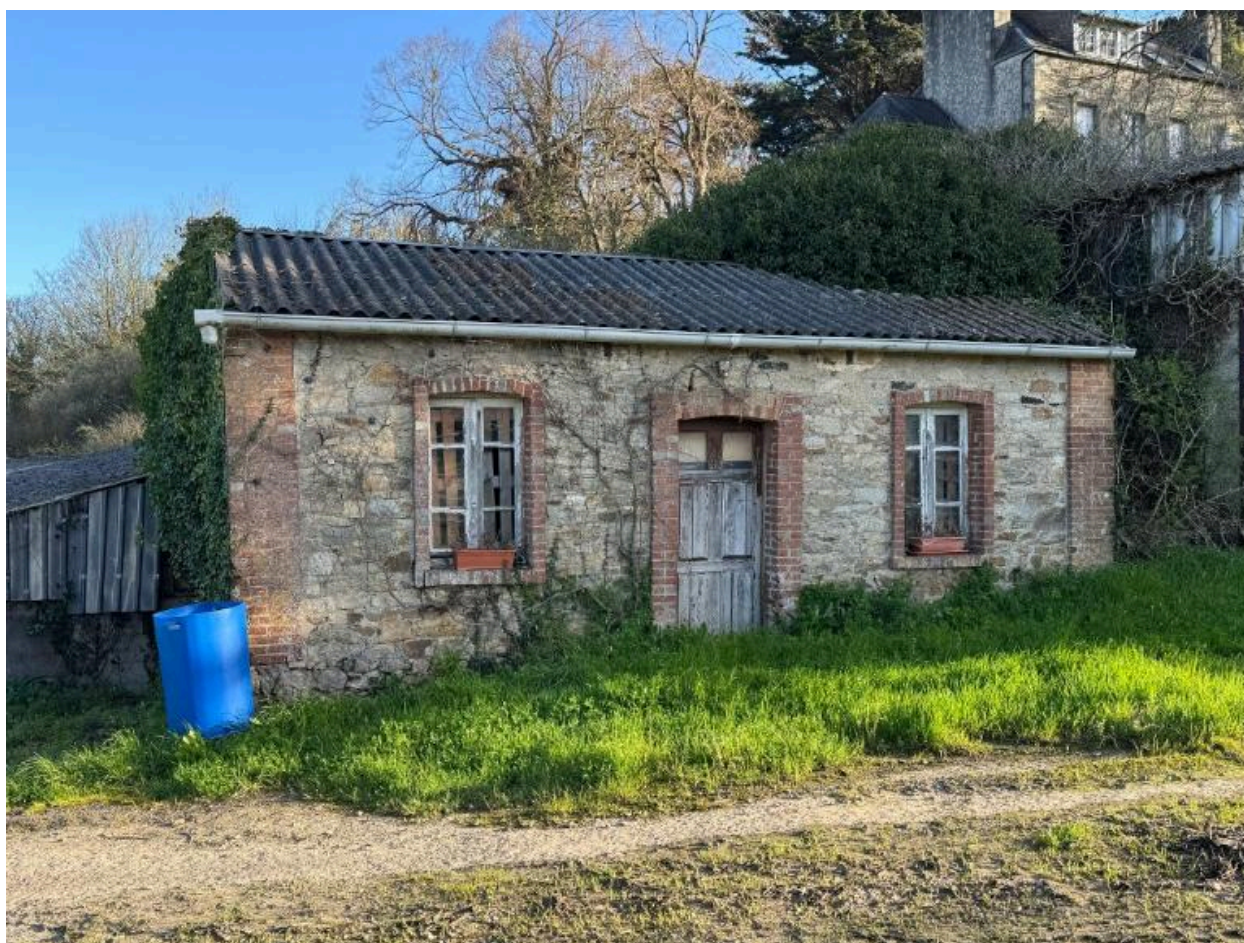
Dépendance. Vue générale sud
