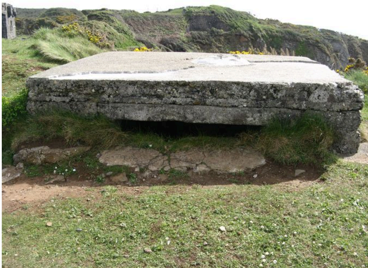
Batterie de mortier allemande à l'ouest de l'île de l'Aber
