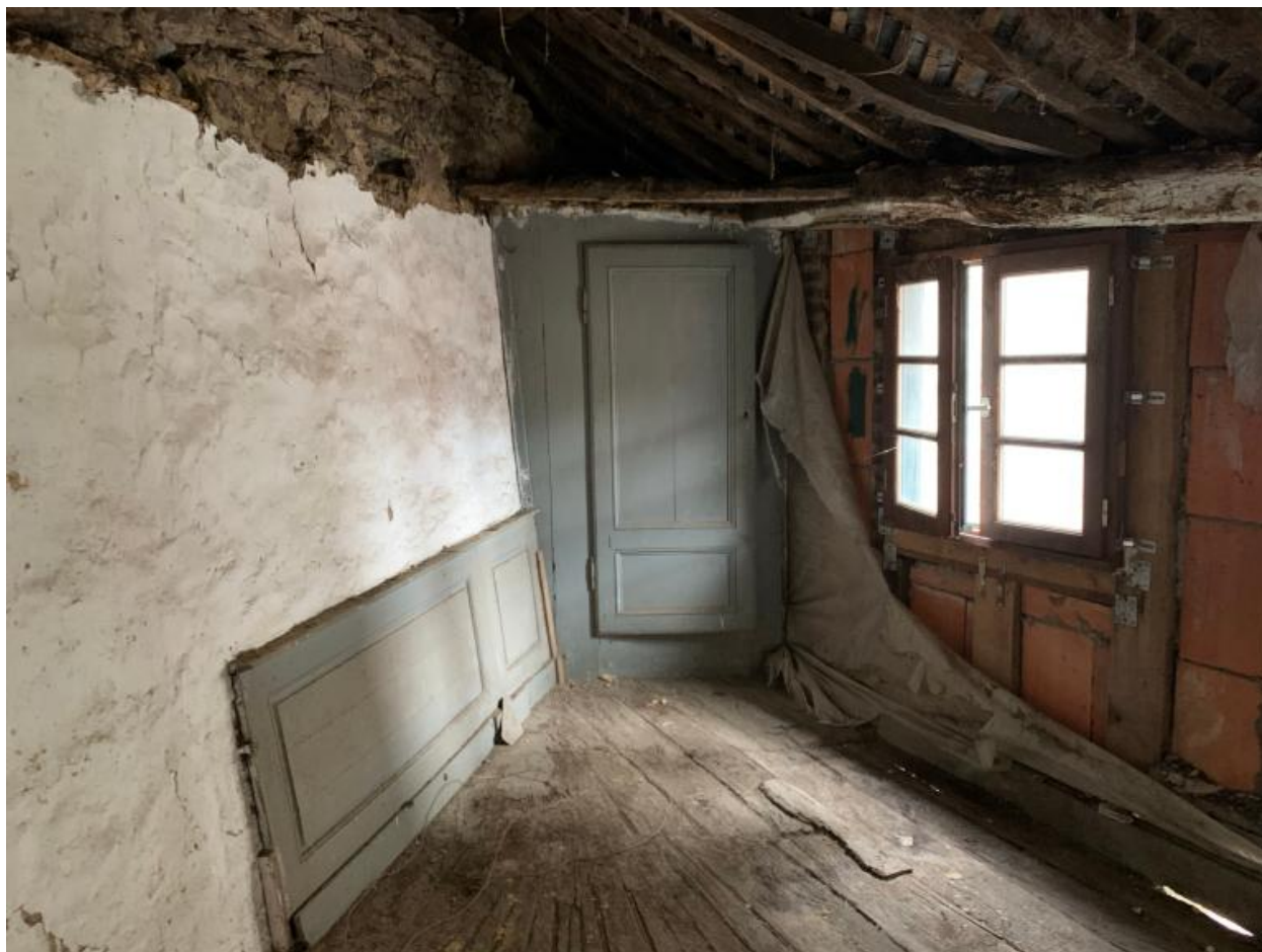
Intérieur, premier étage, pièce ouest
