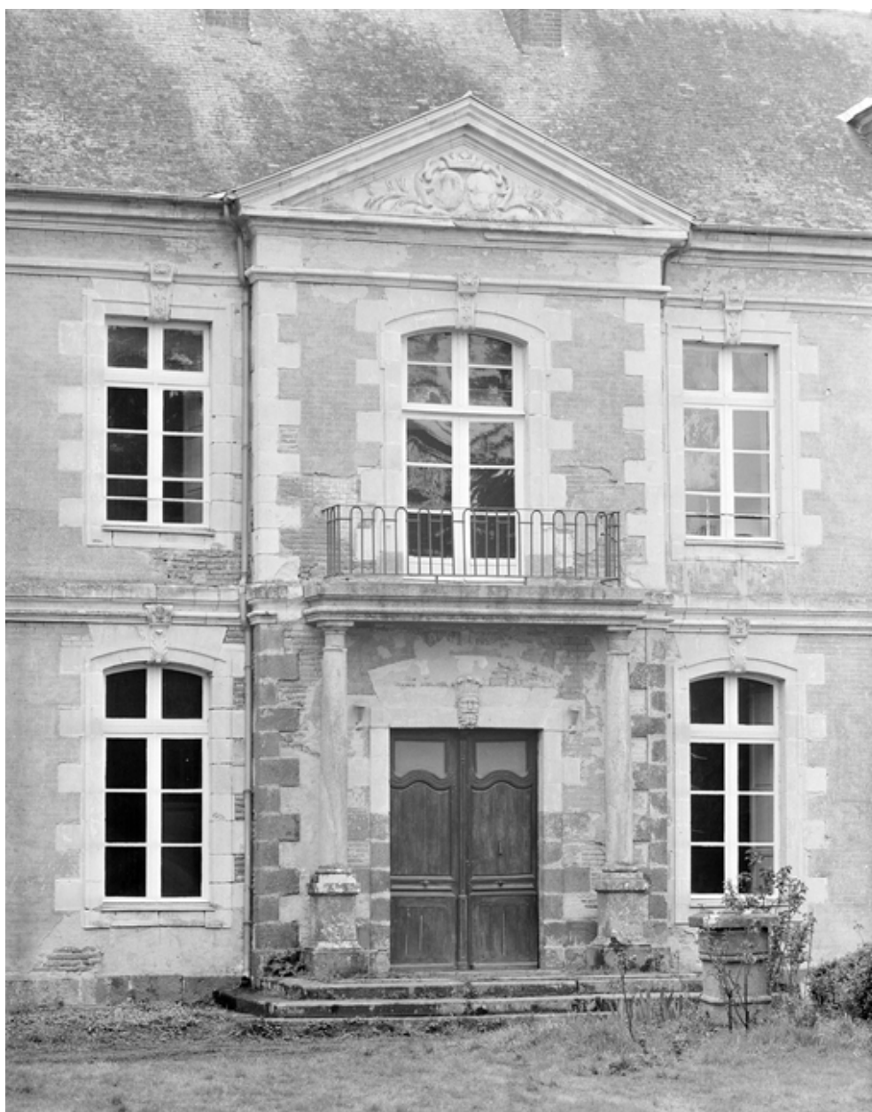
Elévation est, travée centrale.
