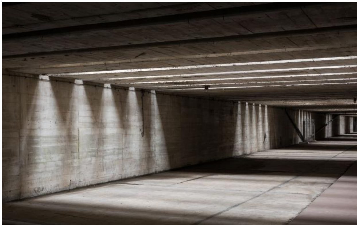
Vue de l'une des chambres d'explosion
