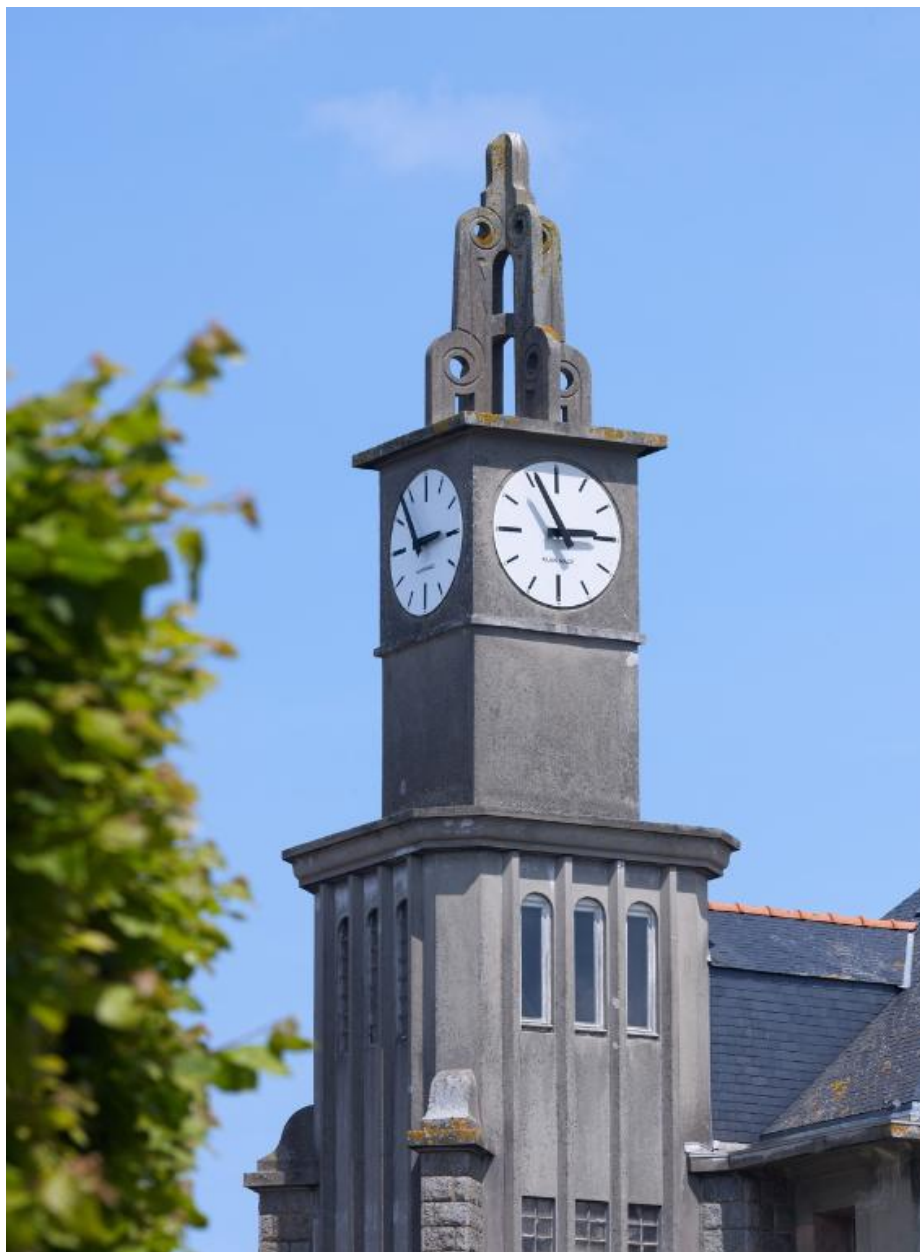
Le beffroi : détail (G-R. Lefort, architecte, 1936-1938).
