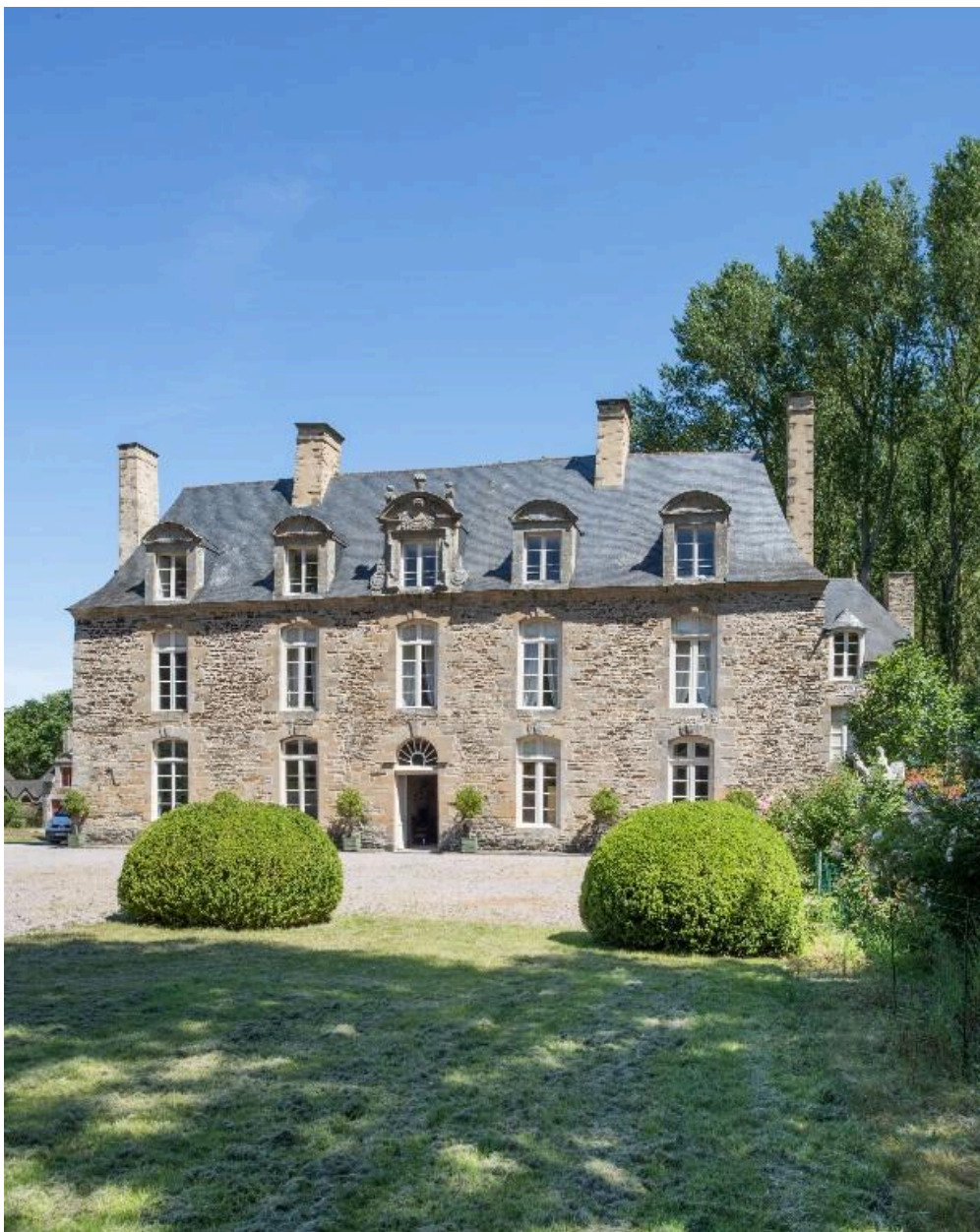
Vue d'ensemble, façade sud
