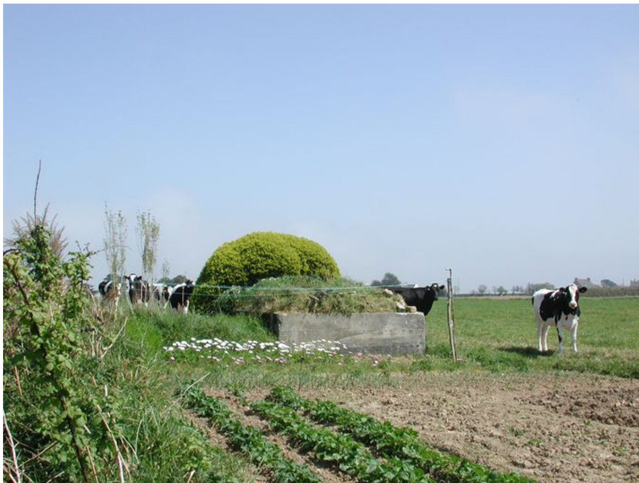
Vue de l'un des bunkers (état en 2002)
