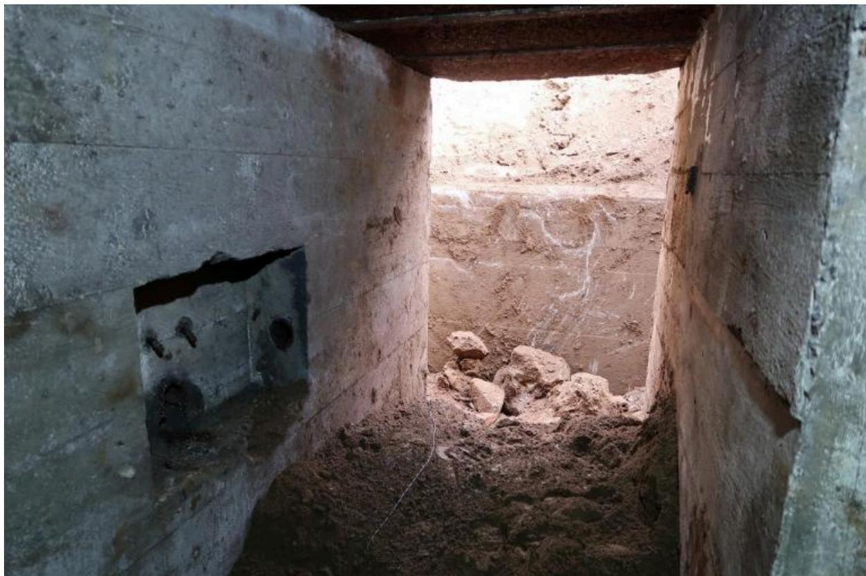
Vue de l'entrée nord [dans le sens de la sortie]. Sur le mur latéral se trouve une niche murale avec passage de câble et fixations. Au fond, le mur de protection en béton armé de la tranchée d'accès
