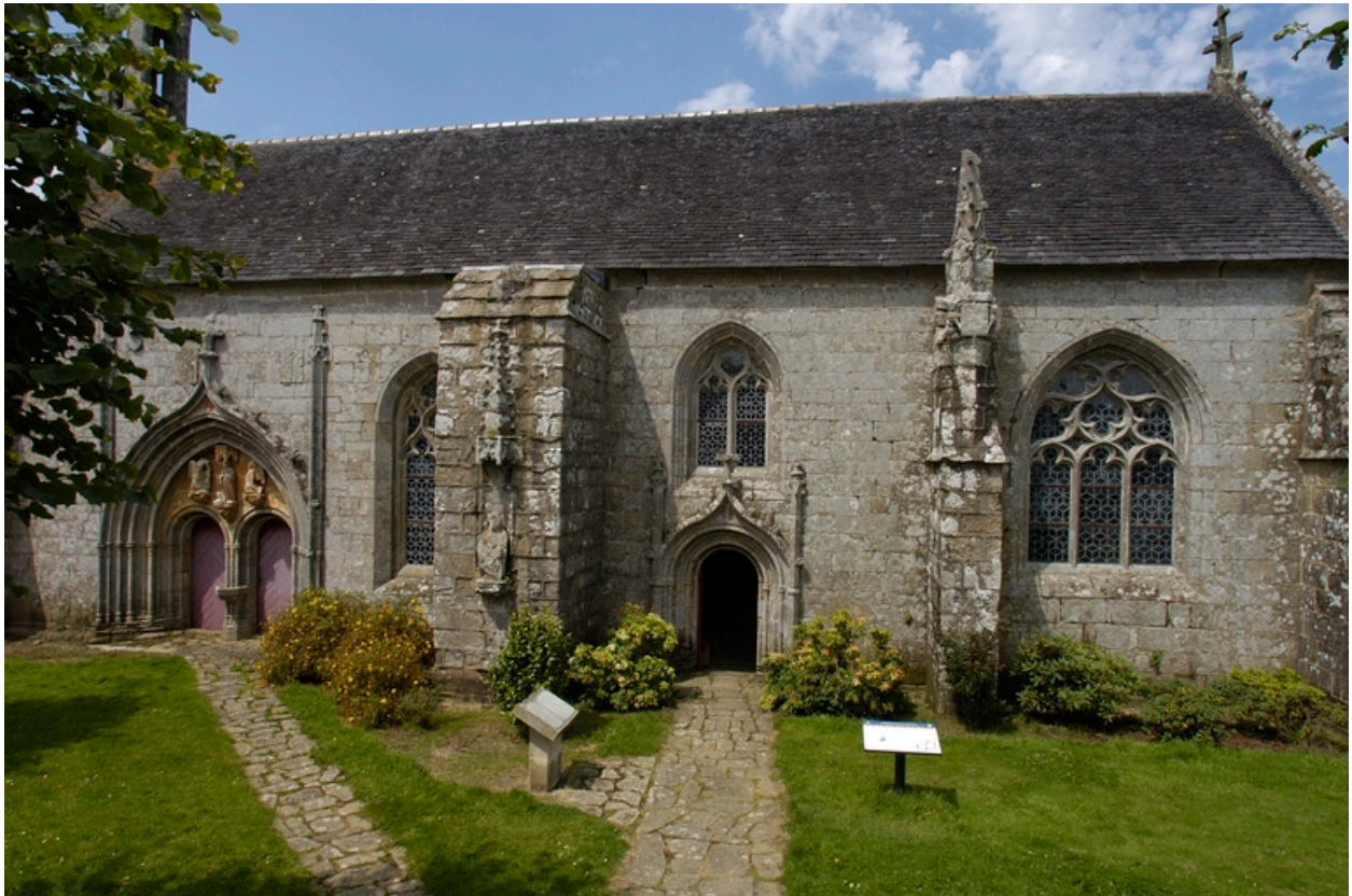
Vue frontale de l'élévation sud
