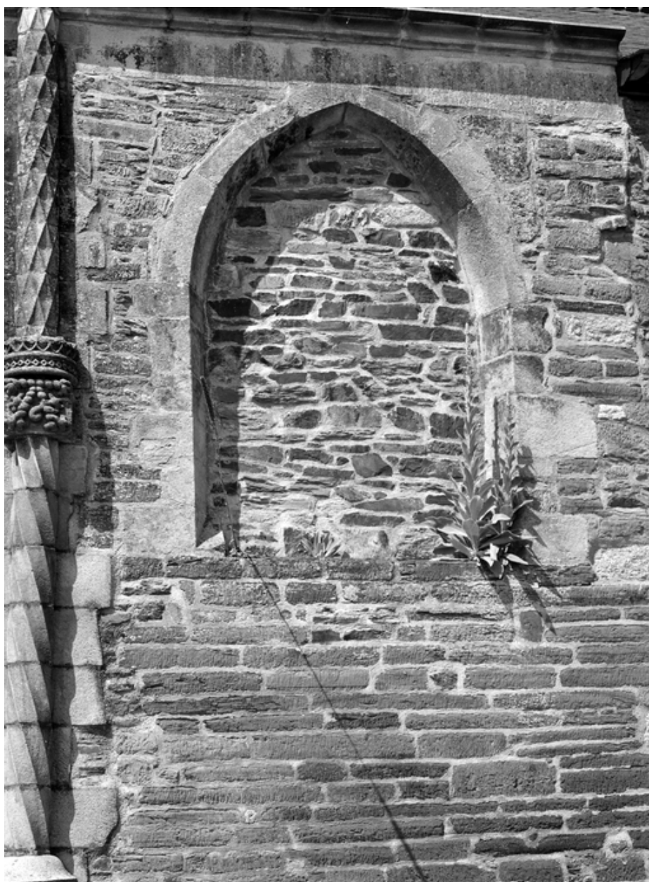
Chapelle, élévation sud, détail : fenêtre bouchée.
