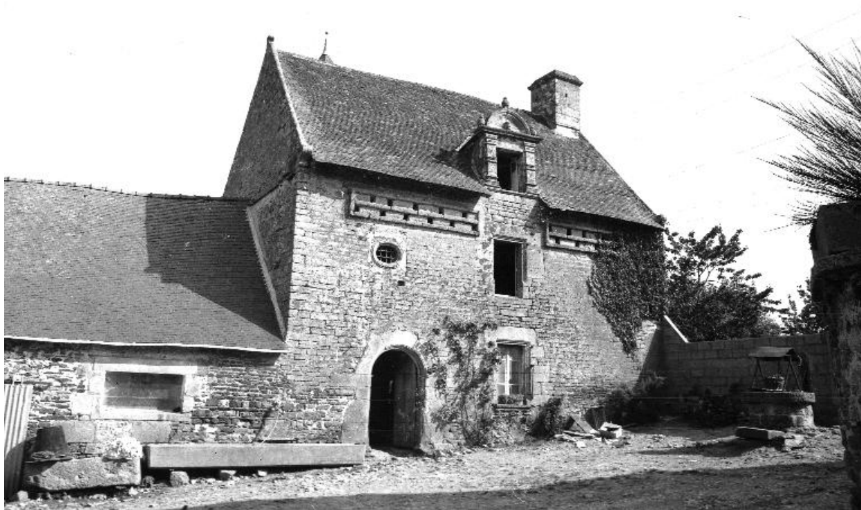
Vue générale de la façade sud.
