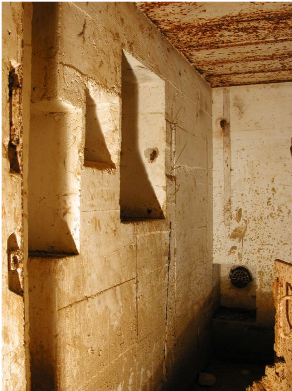
Vue de l'entrée n° 2 (aujourd'hui murée) : créneau blindé de défense d'entrée
