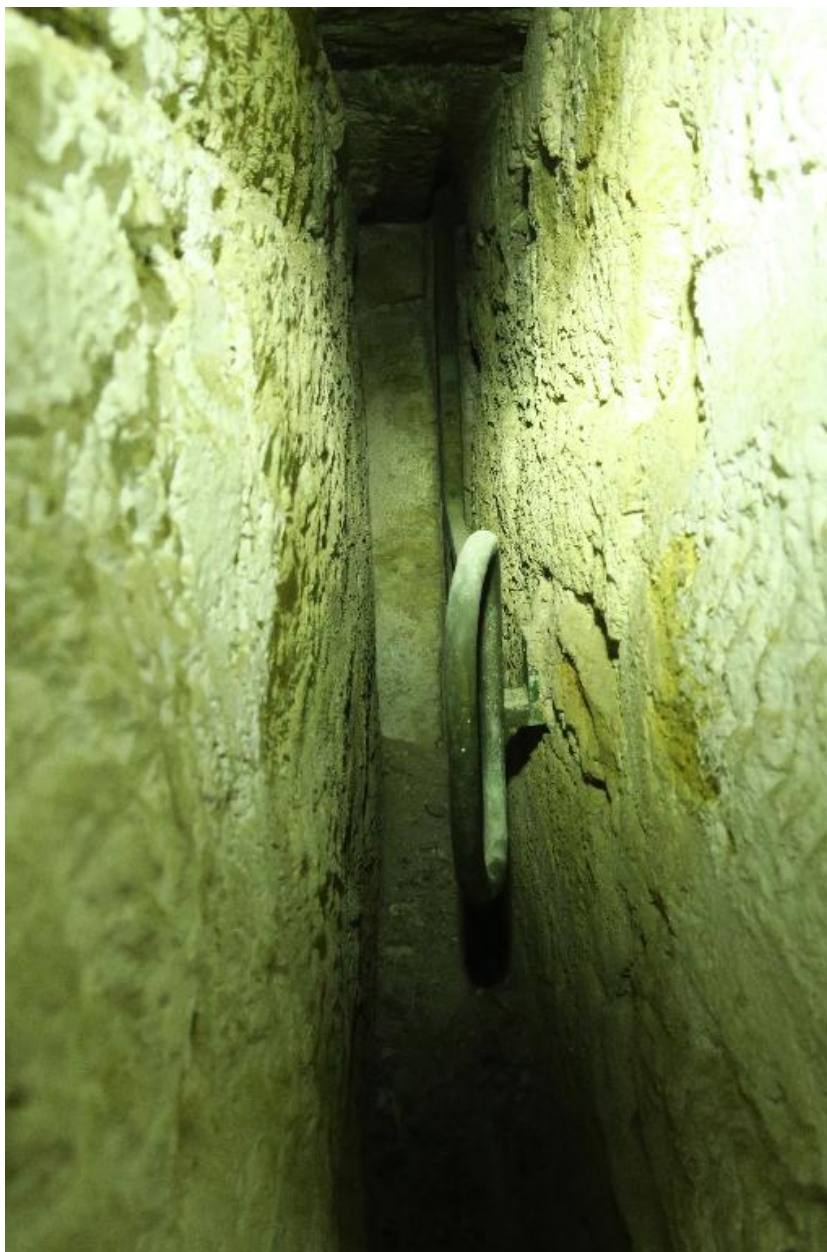
Le Palais, citadelle, magasin à poudre de l'Avancée, évent d'aération, système d'obturation toujours en place.
