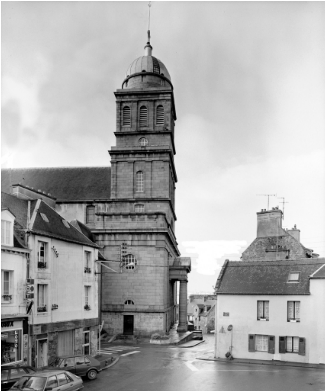
Elévation Sud-Ouest : vue générale
